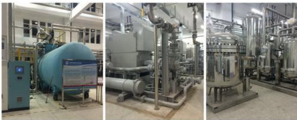
图 1 10kW@20K 大型低温制冷系统
